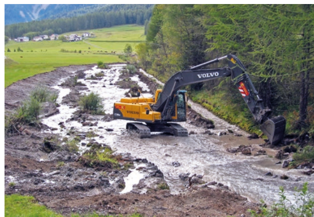
Baubeginn der Revitalisierung 2004. Rechts im Bild ist noch der ursprünglich kanalisierte Rom zu sehen.
