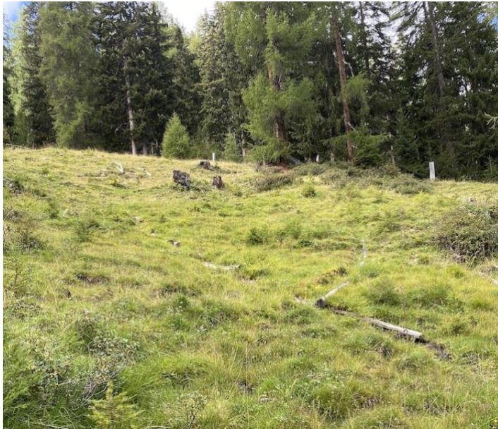
Abbildung 8: Hangabwärtsführende, mit Rundhölzern ausgekleidete Drainagegräben auf Alp Sadra (Mue_0203).
