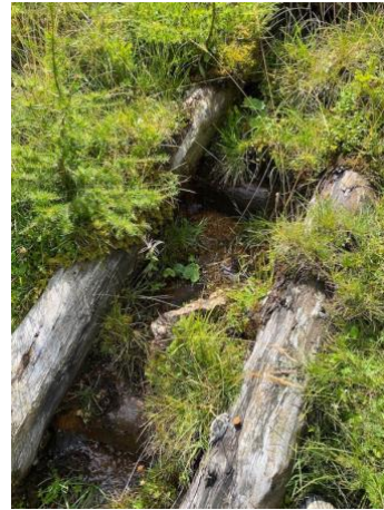
Abbildung 8: Hangabwärtsführende, mit Rundhölzern ausgekleidete Drainagegräben auf Alp Sadra (Mue_0203).
