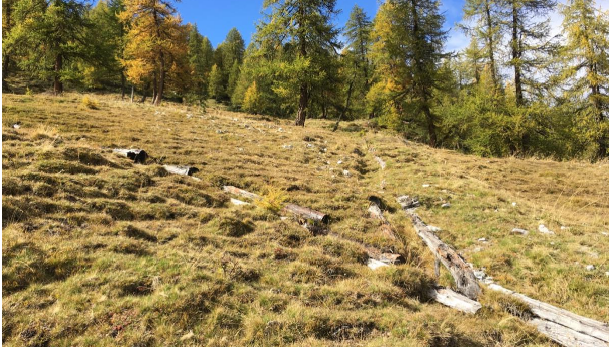
Abbildung 4: Hangabwärtsführende, mit Rundhölzern ausgekleidete Drainagegräben auf Alp Sadra.
