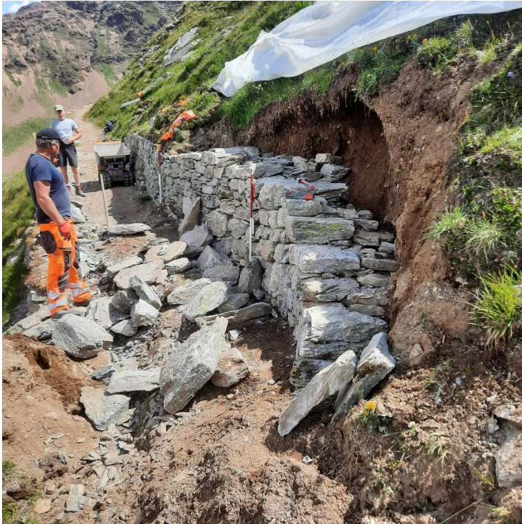
Abbildung 6: Instandstellung der hangseitigen Stützmauer bei Serpentine Nr. 8 zur Hangsicherung.
