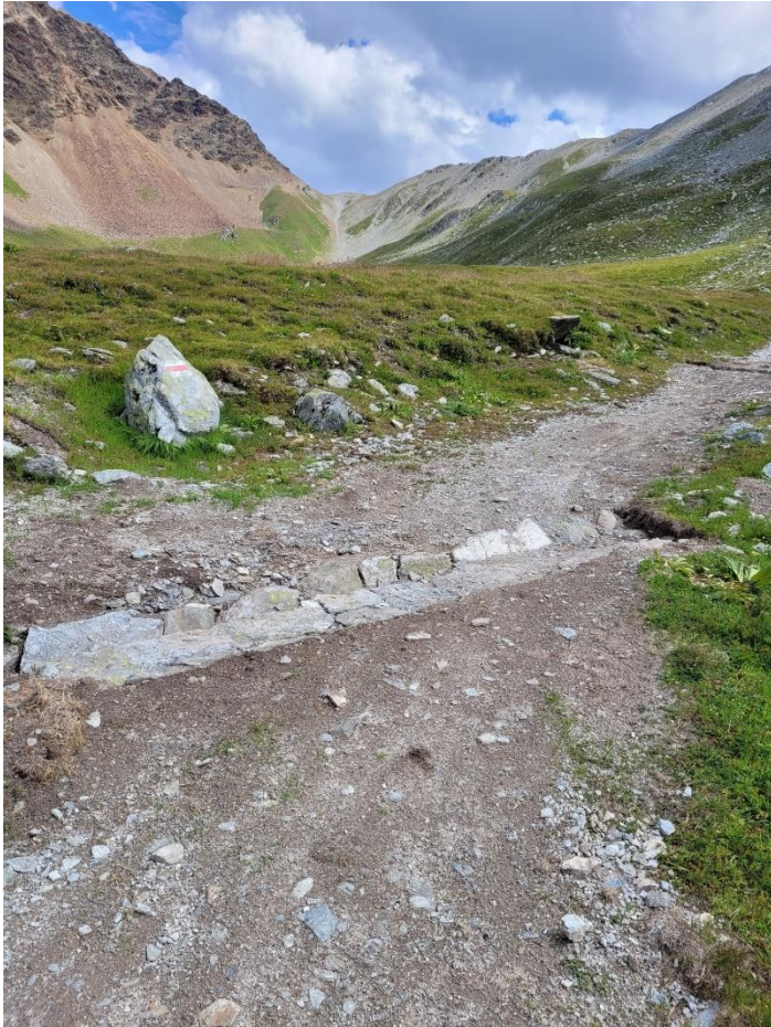
Abbildung 2: Derselbe Ort mit neuem Querabschlag.
