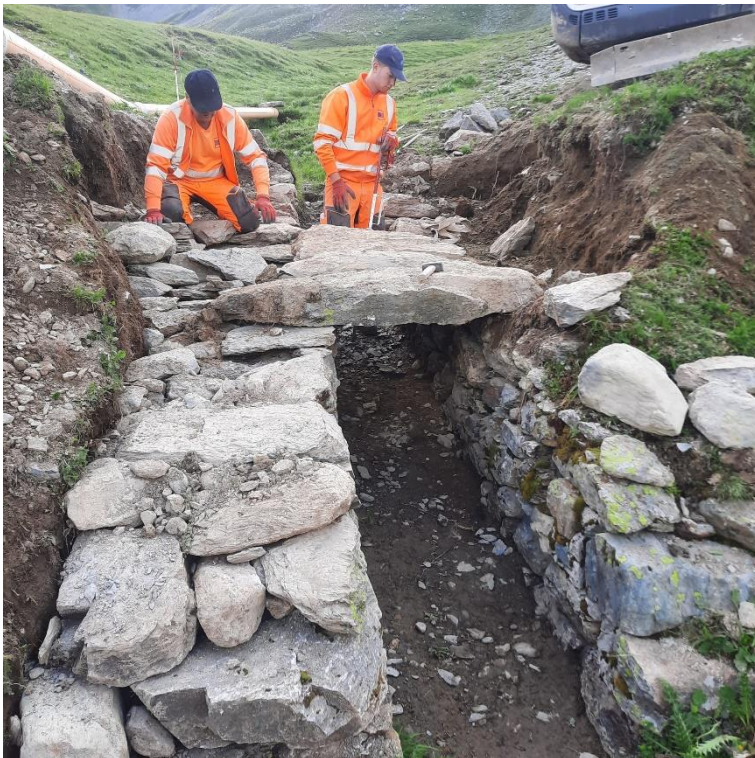
Abbildung 3: Reparatur eines eingestürzten Wasserdurchlasses.
