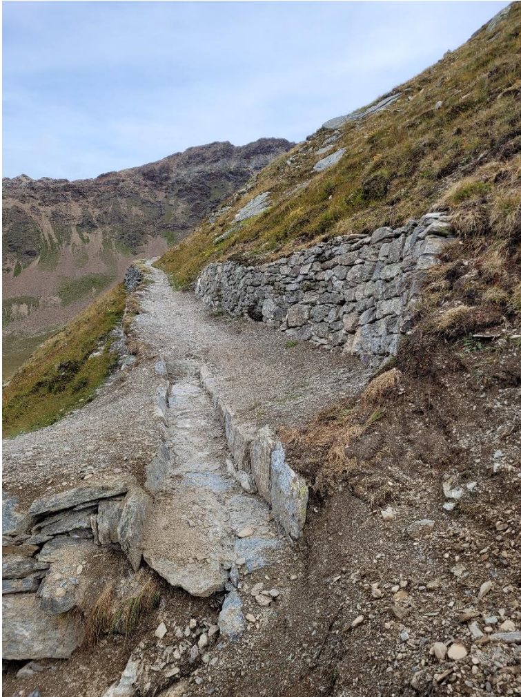
Abbildung 7: Serpentine Nr. 8 nach der Instandstellung.
