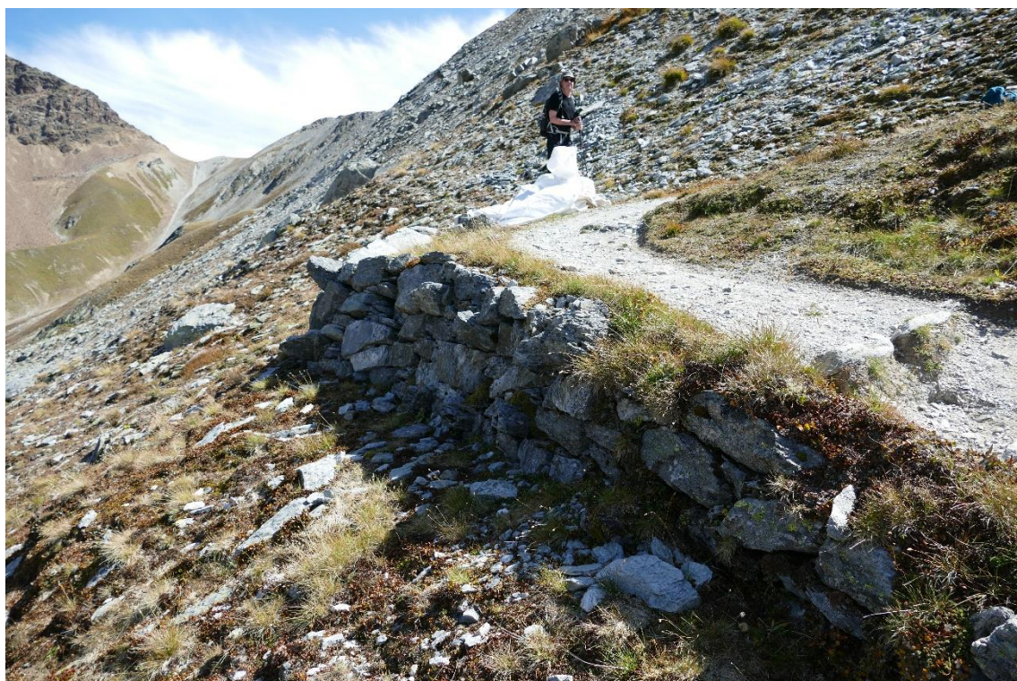
Abbildung 10: Abgesackte Serpentine Nr. 11.
