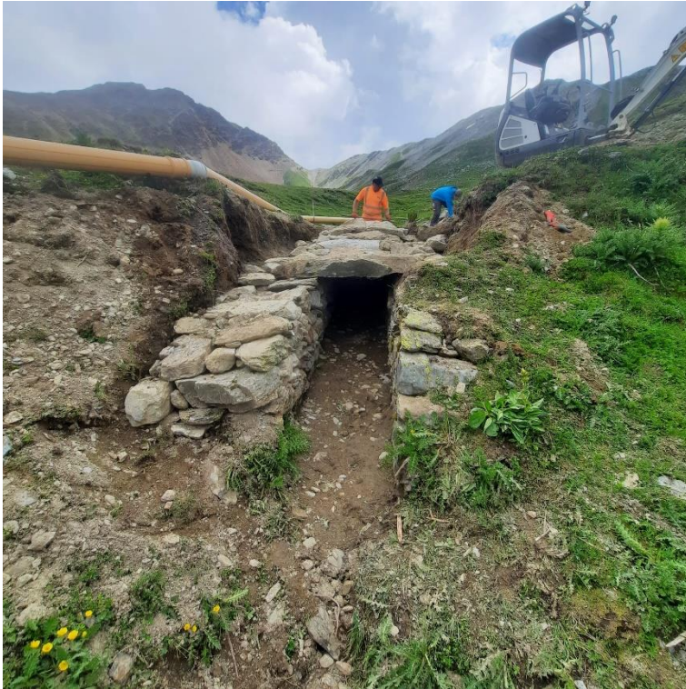
Abbildung 4: Derselbe Durchlass beim Eindecken mit Steinplatten.
