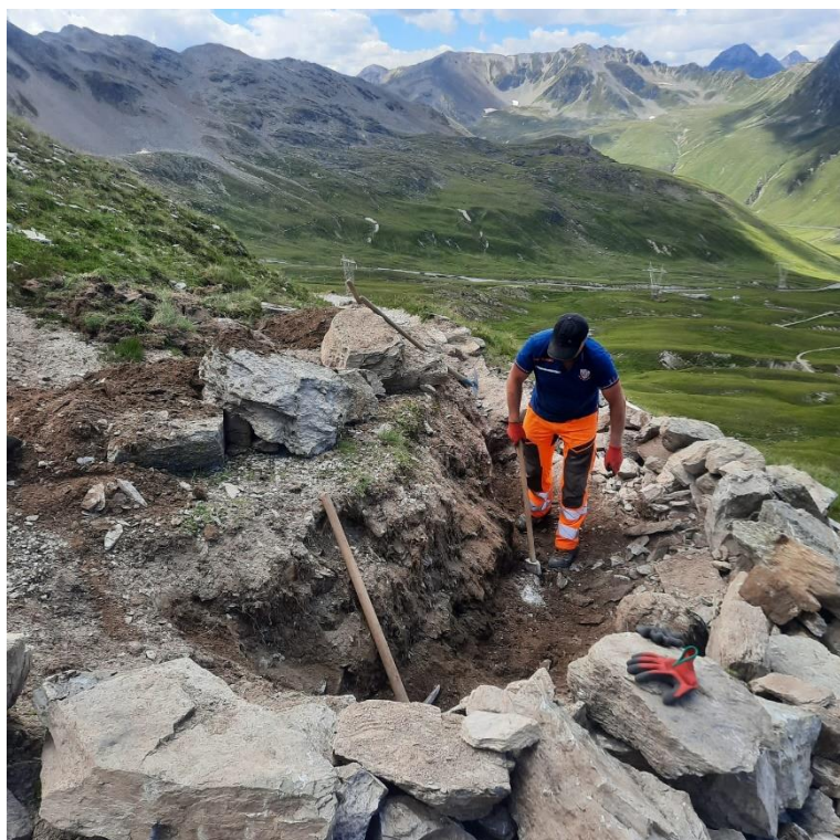
Abbildung 11: Reparatur der Serpentine Nr. 11. Der Maschineneinsatz ist kaum möglich. Die Steine müssen von Hand gesetzt werden.
