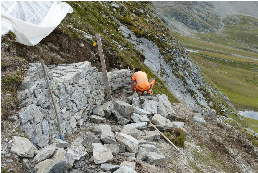
Abbildung 5: Eine Stützmauer in den Serpentinien wird erneuert.
