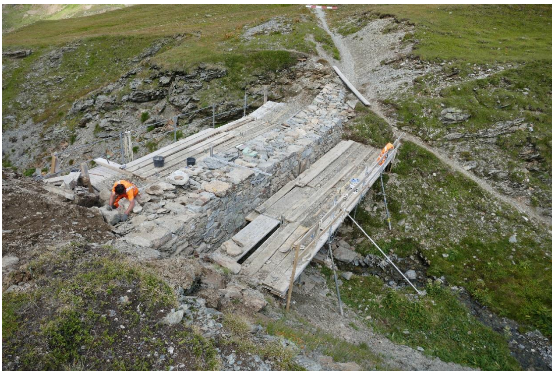
Abbildung 3: Die Brücke musste aus stabilitätsgründen teilweise abgetragen und der obere Teil neu aufgemauert werden. Beim öffnen der Konstruktion wurde ersichtlich, dass zwischen den Mauern mit Erde und Feinmaterial aufgefüllt wurde, wohl um die Brücke schnell zu erstellen. Zwischen den Mauern wurde nun eine Hintermauerung aus Steinen eingebracht.
