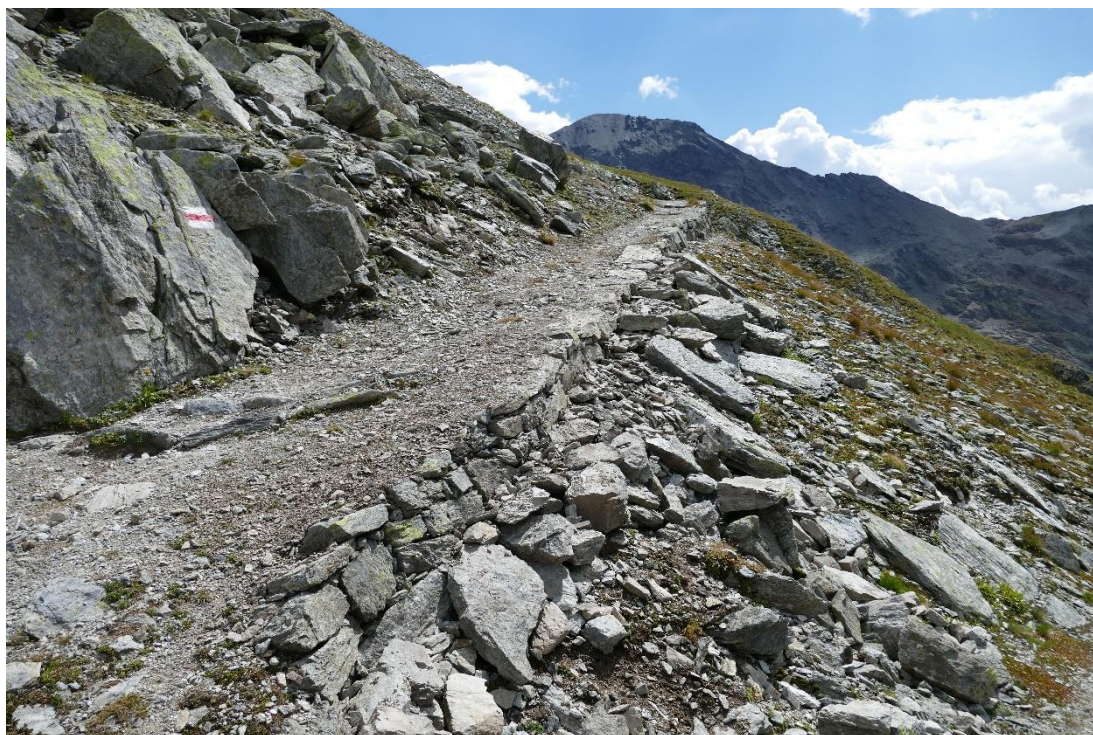
Abbildung 8: Auf diesem Abschnitt wurde die Mauerkrone wieder gerichtet und die Wegoberfläche ausgebnet.
