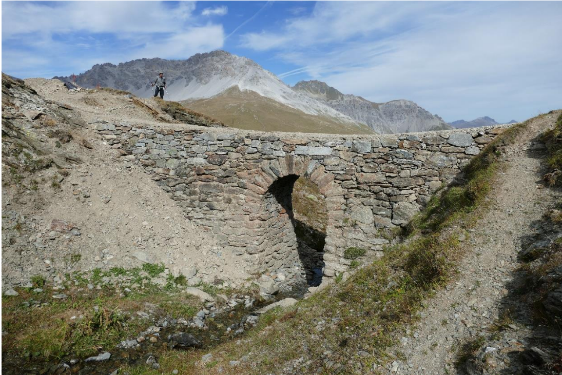
Abbildung 4: Muranzinabrücke nach der Instandstellung.
