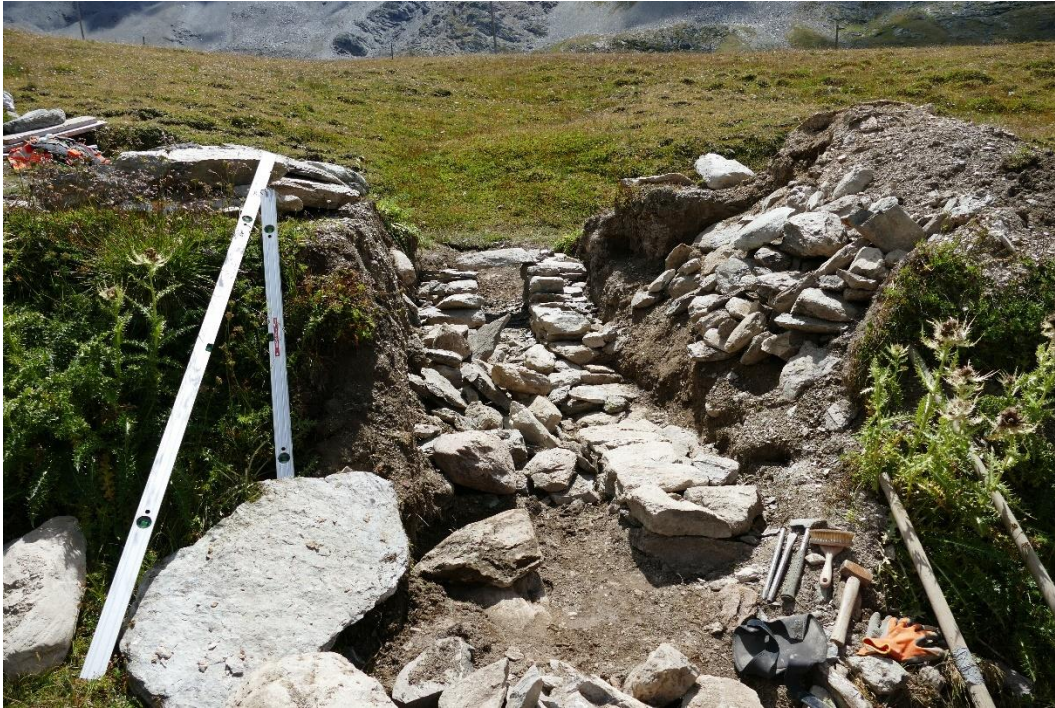
Abbildung 11: Für die Instandsetzung geöffneter Wasserdurchlass.
