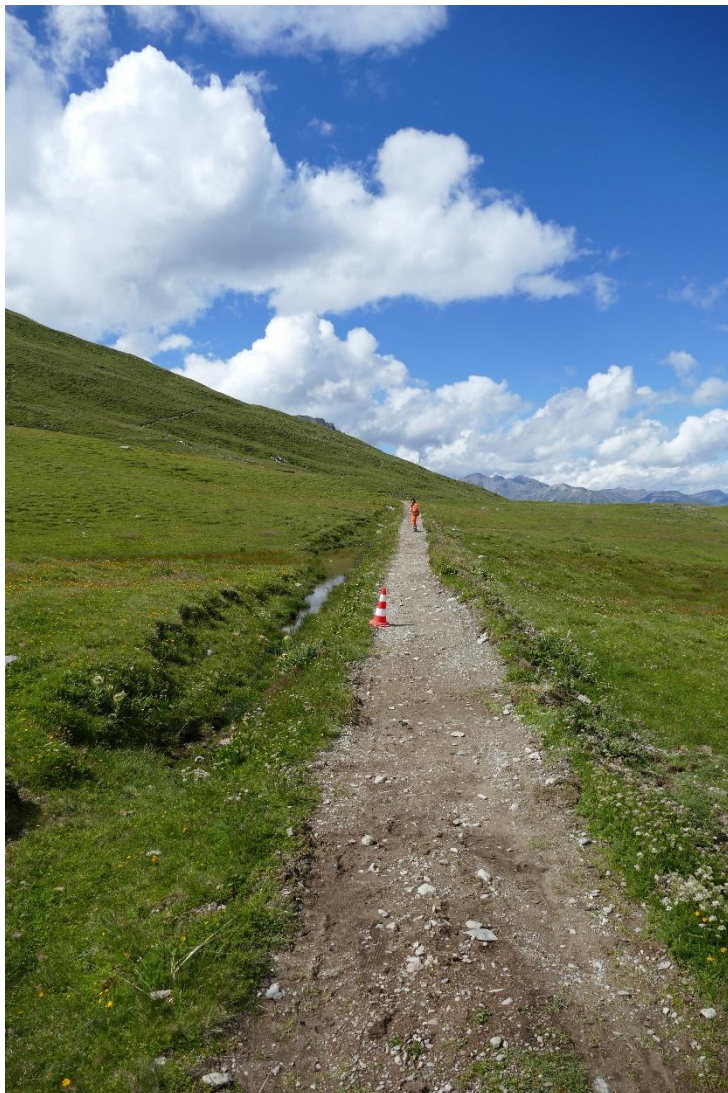
Abbildung 5: Wegabschnitt nach der Instandsetzung. Die Grassoden wurden zur Befestigung der Wegschulter eingesetzt.
