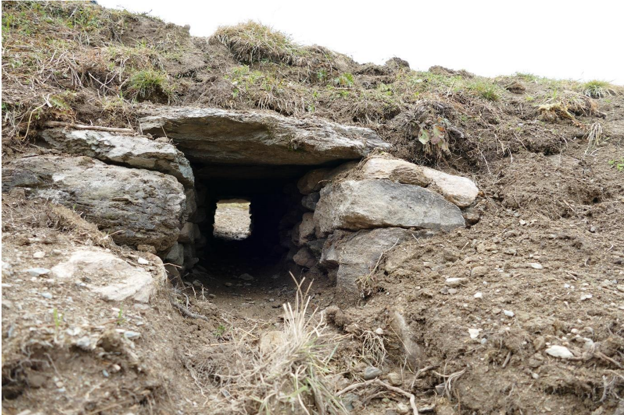
Abbildung 13: Der Durchlass nach der Instandstellung.
