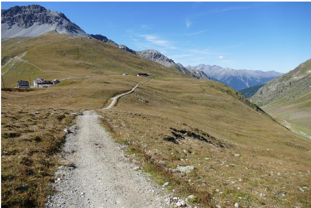
Abbildung 3: Blick in Richtung Umbrailpass nach den Instandsetzungsarbeiten.
