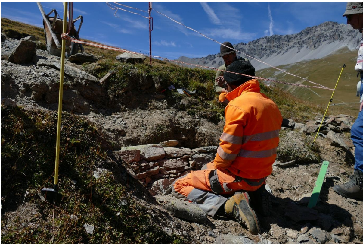
Abbildung 4: Befestigung der Wegschulter mit Steinen. Die gemauerte Befestigung wird anschliessend wieder eingedeckt.
