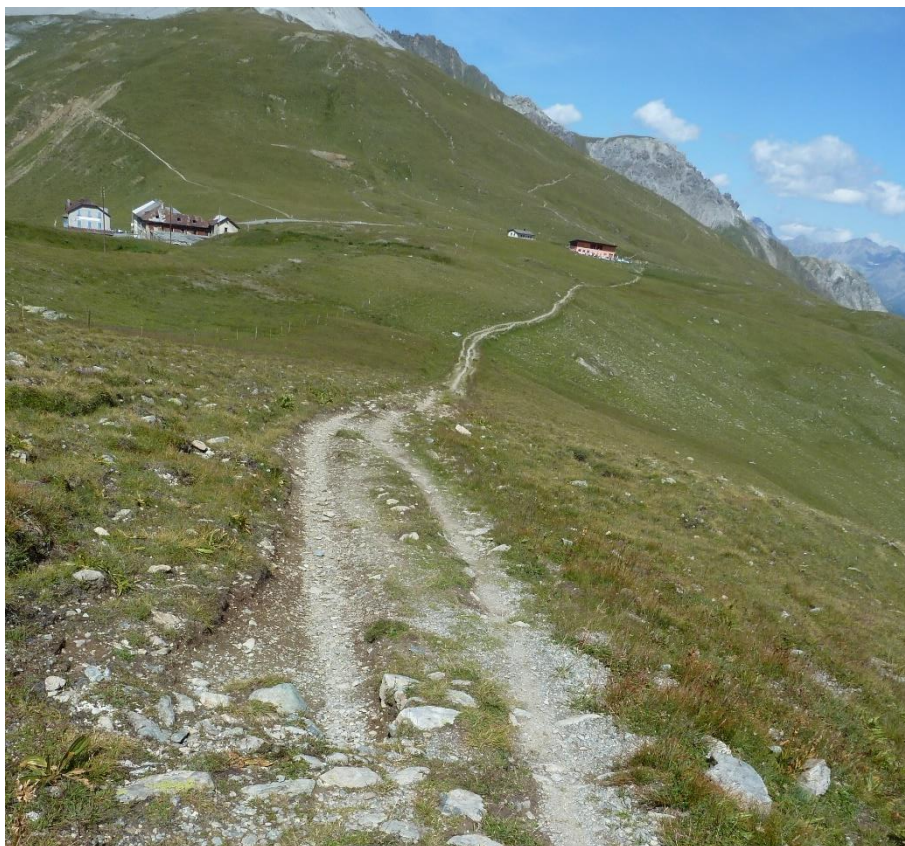
Abbildung 2: Blick in Richtung Umbrailpass vor dem Abschälen der Wegoberfläche.
