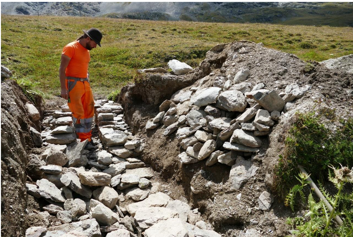
Abbildung 12: Bereits relativ kleine Durchlässe sind sehr arbeitsintensiv.
