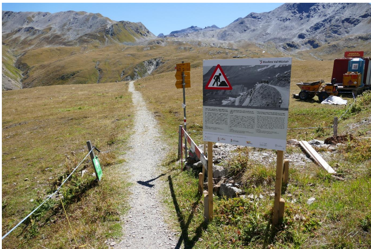
Abbildung 1: Baustelleninformation zu Beginn des Weges an der Umbrailpasstrasse.
