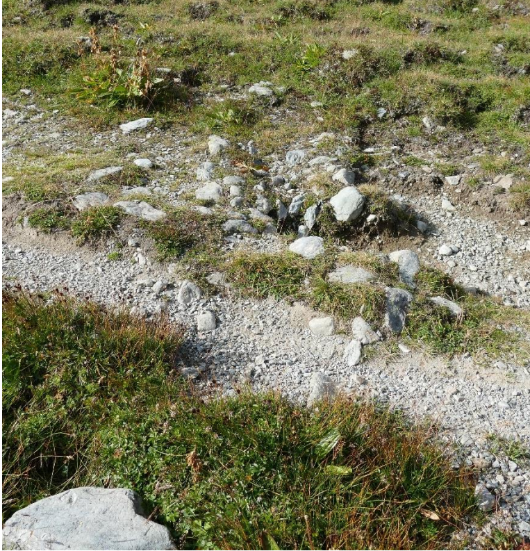
Abbildung 6: Reste eines Querabschlags. Die Funktion ist nichtmehr gegeben.
