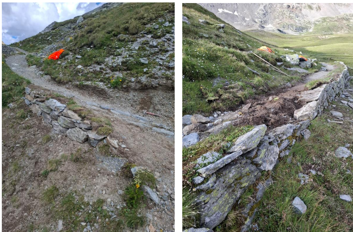
Abbildung 4: Relativ kleine aber arbeitsintensive Arbeiten zur Stabilisierung von kleineren Mauern in reiner Handarbeit.
