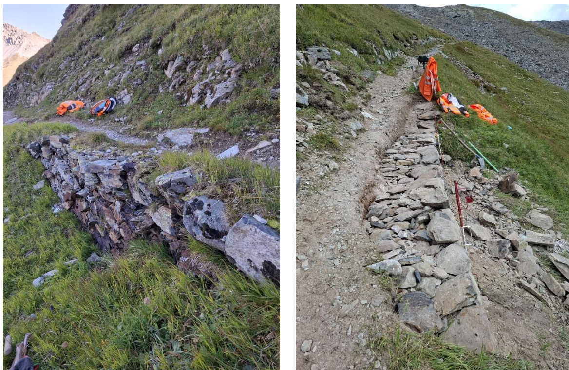
Abbildung 2: Stützmauer oberhalb der Serpentin vor und während der Instandstellung.
