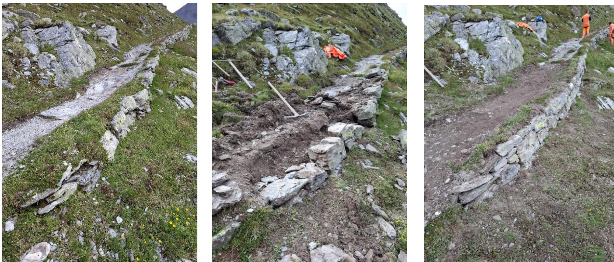
Abbildung 5: Ausbesserung einer Mauer. Vor, während und nach der Ausführung.
