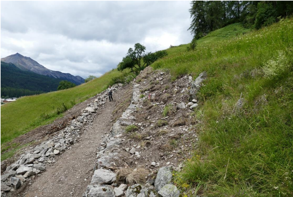
Abbildung 16: Situation auf der Mauerkrone nach der Fertigstellung.
