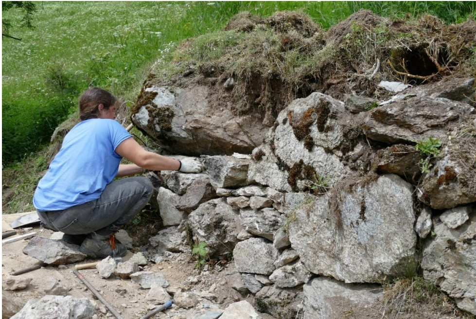
Abbildung 8: Sorgfältige Reparatur eines Teilabschnittes.
