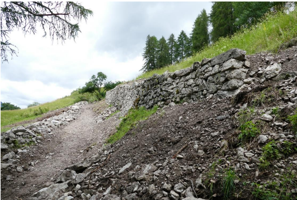
Abbildung 13: Der untere Bauabschnitt kurz nach der Fertigstellung.
