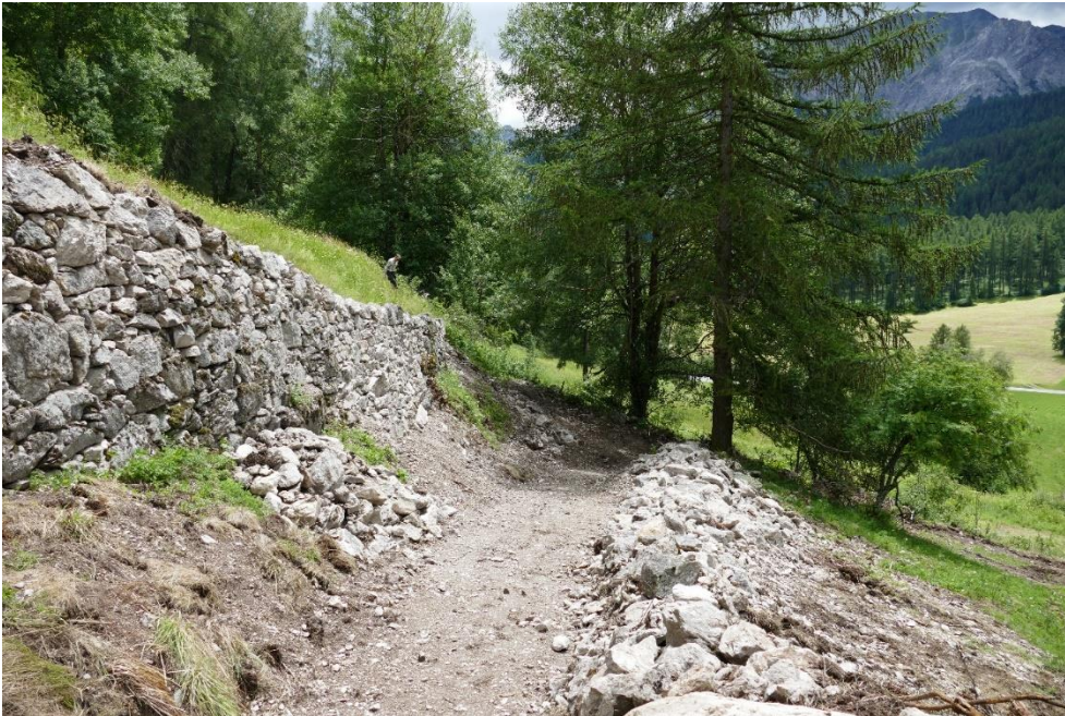
Abbildung 18: Bei einzelnen Bereichen wurde eine Rollierung erstellt, um die Stabilität von alten Mauerabschnitten sicherzustellen.
