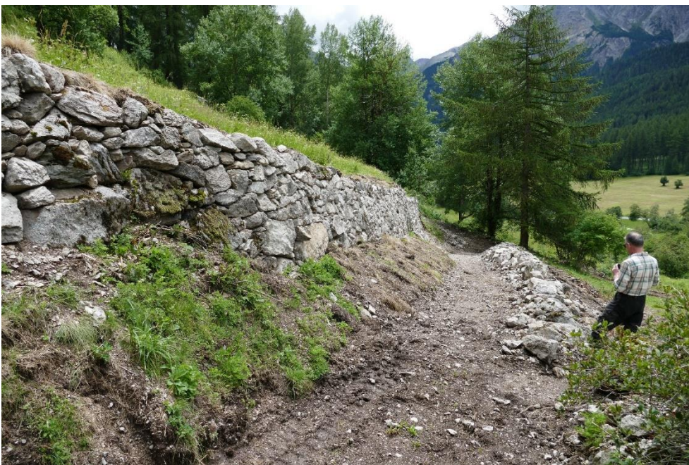
Abbildung 15: Abnahme der Baustelle mit der Fachperson für historische Verkehrswege. Zur Begrünung des Mauerfusseses wurden Grassoden verwendet, die vor der Ausführung beiseitegelegt wurden.
