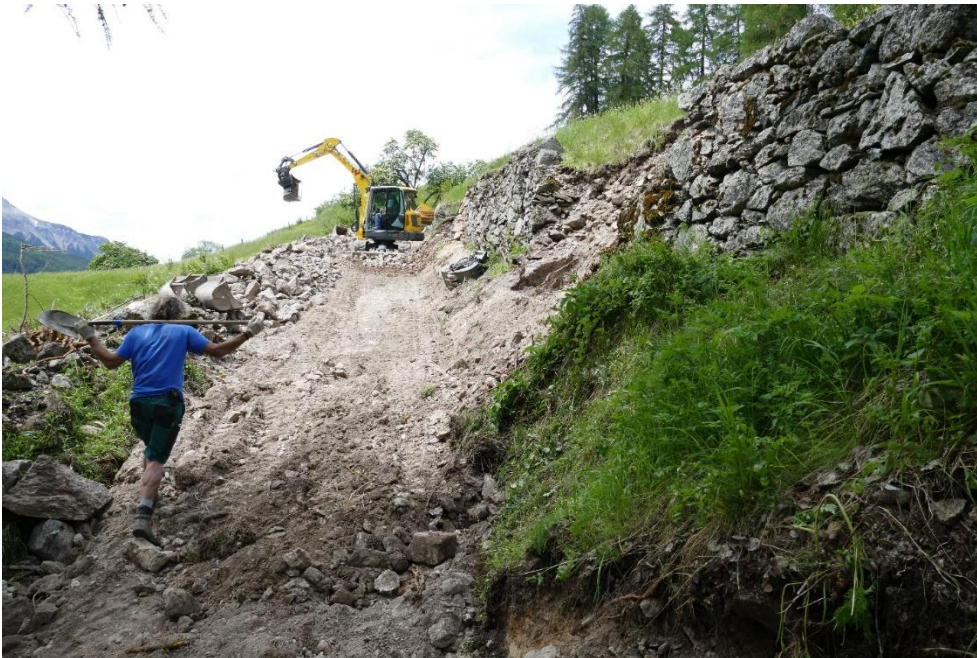
Abbildung 5: Unterer Bauabschnitt während Instandstellung. Der Hohlweg wurde zum Schutz teilweise aufgefüllt und als "Piste" für den Bagger verwendet.
