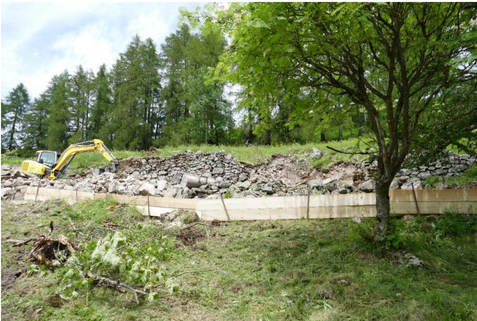
Abbildung 7: Bauarbeiten von unten betrachtet. Einzelne Mauerabschnitte wurden repariert und belassen.
