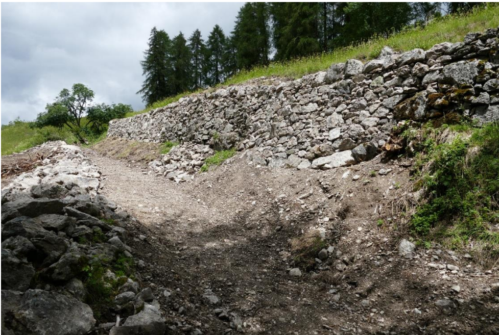
Abbildung 17: Alte und instand gestellte Mauerabschnitte. Am linken Bildrand der Lesesteinwall, welcher für das Objekt charakteristisch ist.
