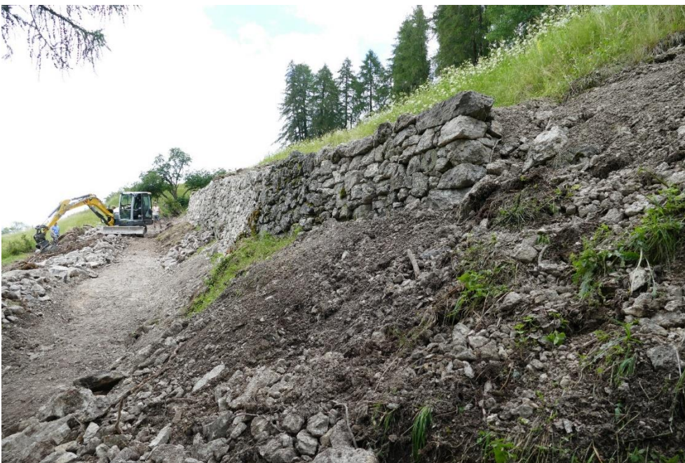
Abbildung 11: Unterer Bauabschnitt kurz vor Bauabschluss. Der Hohlweg wird wiederhergestellt.
