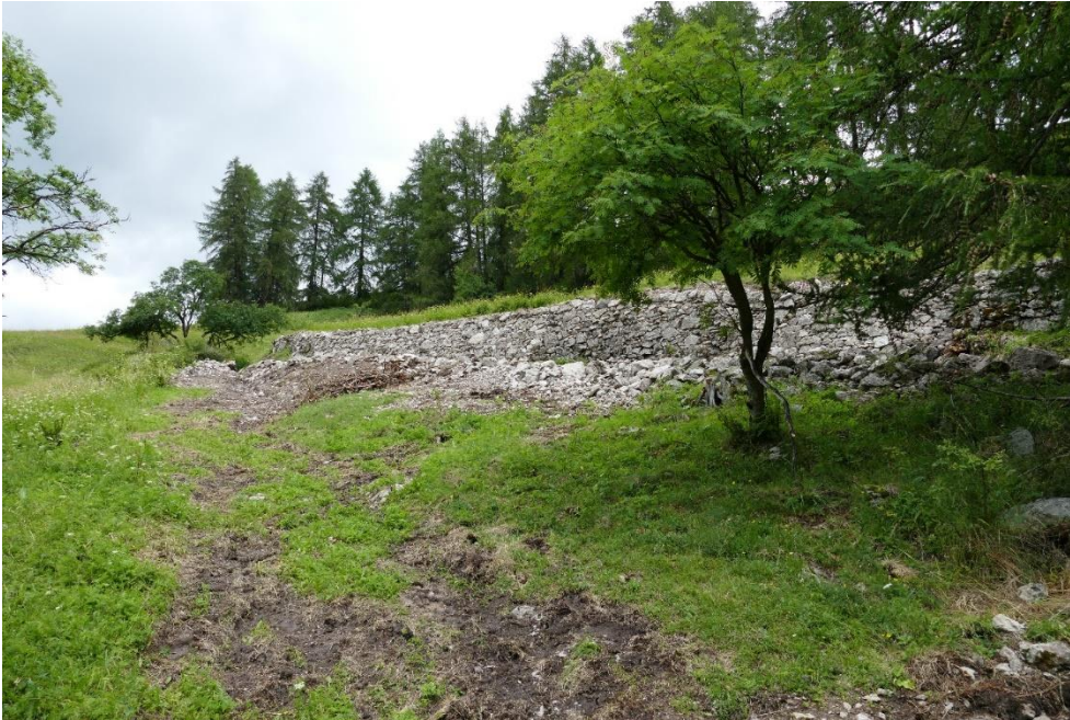
Abbildung 12: Die Baustelle nach der Fertigstellung von unten betrachtet.
