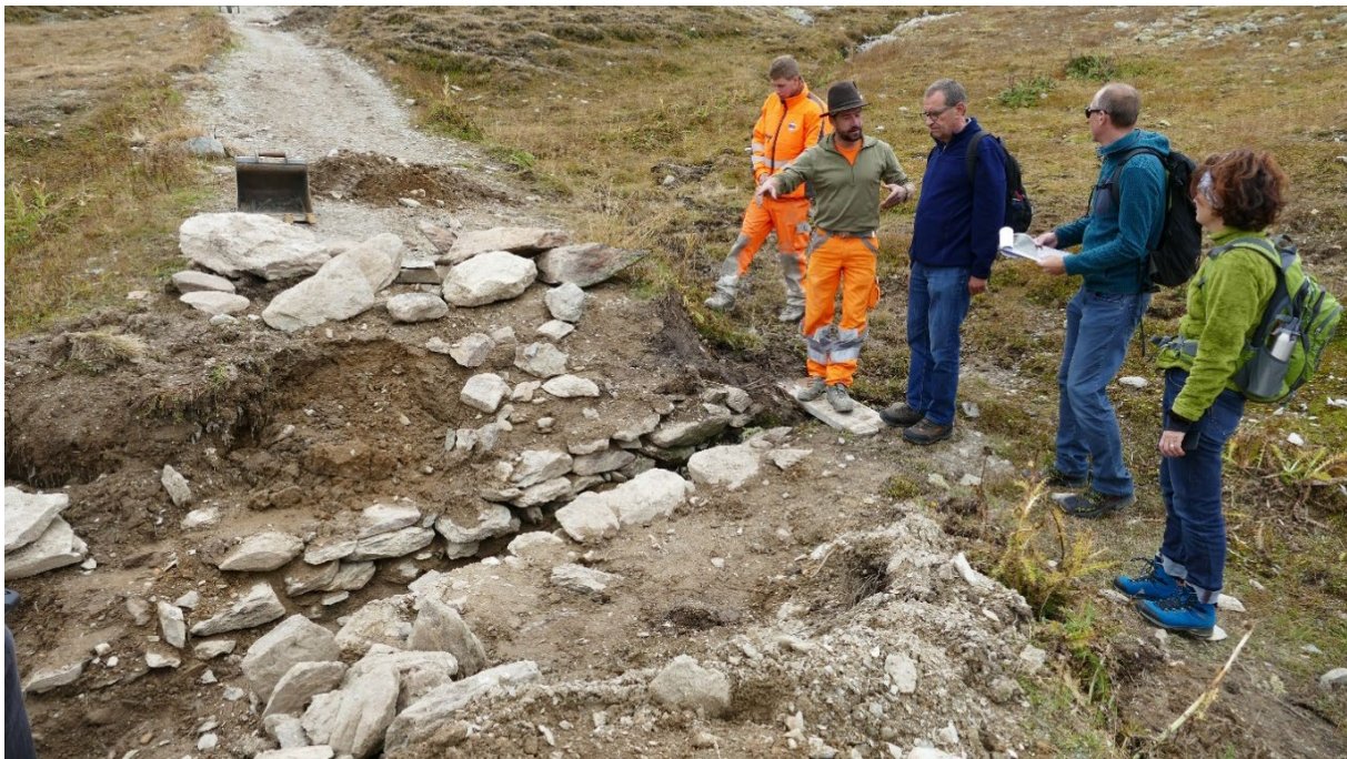
Abbildung 5. Instandstellung des historischen Verkehrsweges von nationaler Bedeutung zur Dreisprachenspitze. Fachlicher Austausch zur Ausführung eines Wasserdurchlass zwischen dem Bauleiter und Verantwortlichen des ASTRA auf einer Baustellenbegehung (Bild: David Spinnler).
