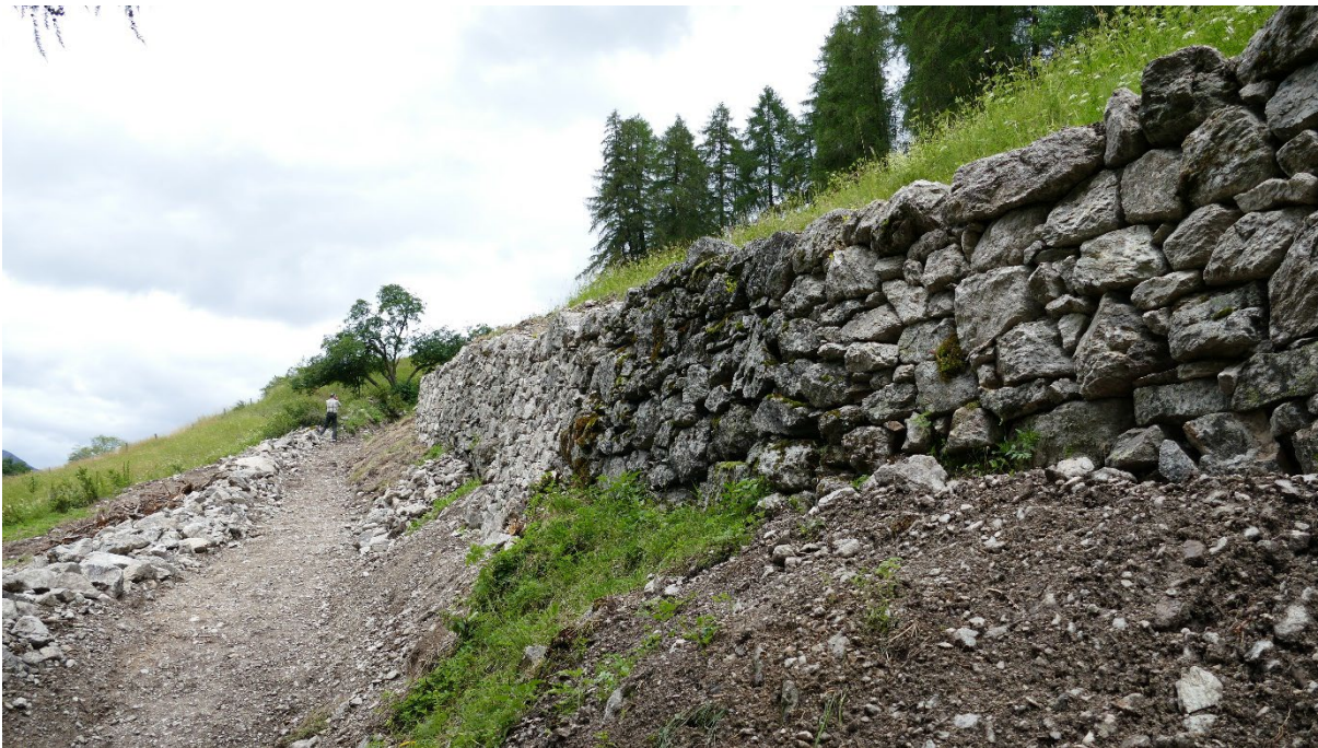
Abbildung 4. Instandgesetzter Abschnitt des historischen Verkehrsweges zwischen Punt Lü und Lüsai kurz nach Bauabschluss. Eben erfolgt die Abnahme durch den Experten für historische Verkehrswege (Bild Yves Schwyzer).
