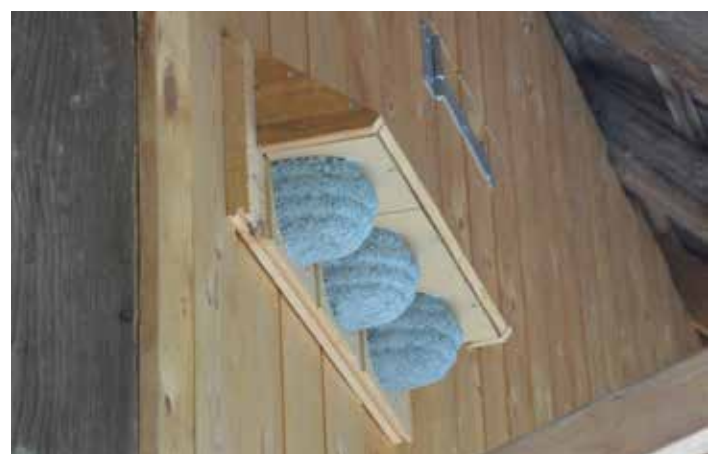
Wenn Kunstnester abgesetzt vom Unterdach angebracht werden, muss oben ein Keil von mindestens 45° angebracht werden, damit Nesträuber nicht auf die Nester sitzen können. © Martina Schybli
