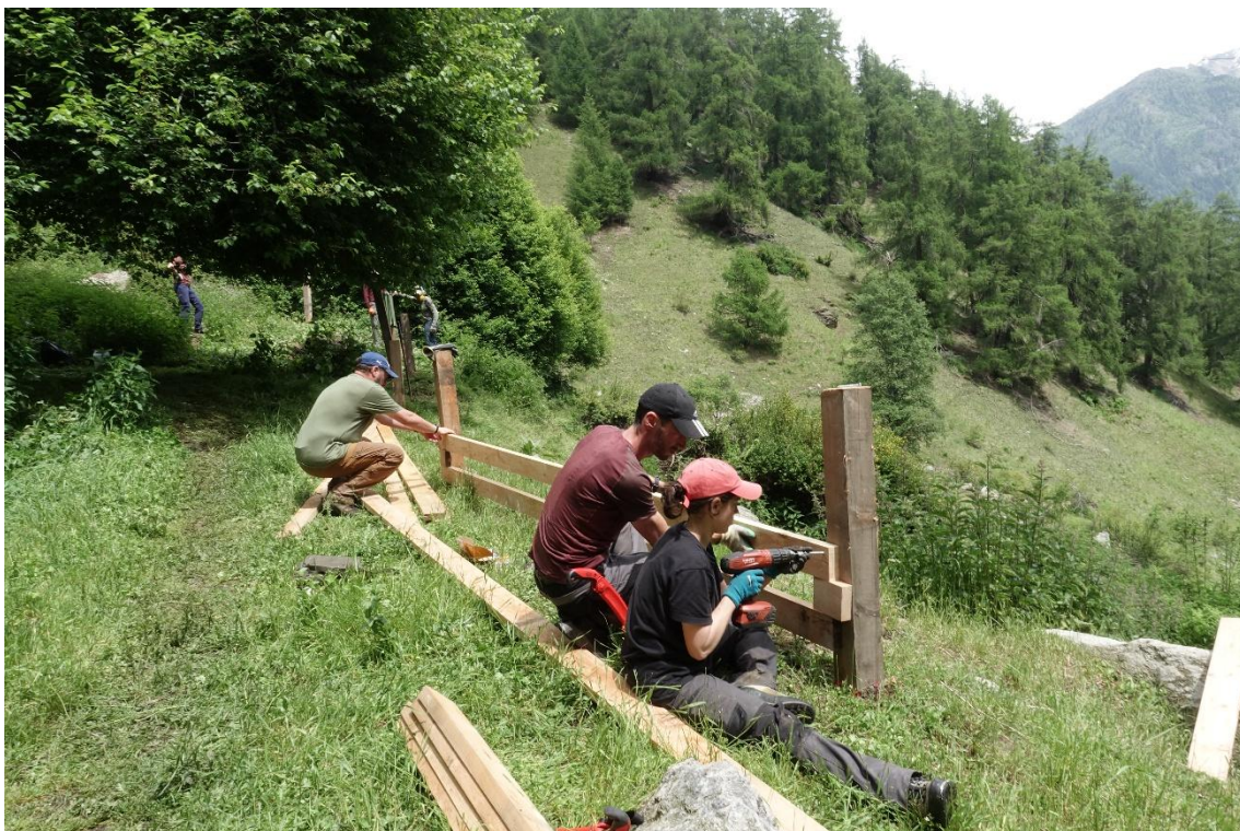
Abbildung 3: Bau eines Holzzaunes als Koppel um die Herde zusammenzutreiben und zur besseren Lenkung aus Herdenschutzgründen. (Bild: Bergwaldprojekt)
