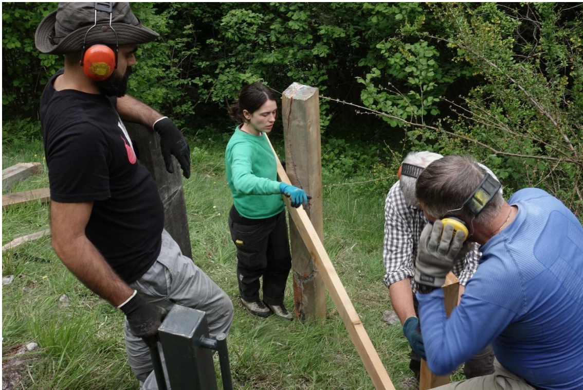
Abbildung 2: Reparatur des defekten Zaunes bei Munt da Sach und Wechsel von Drahtlitzen auf das Bändersystem. (Bild: Bergwaldprojekt)
