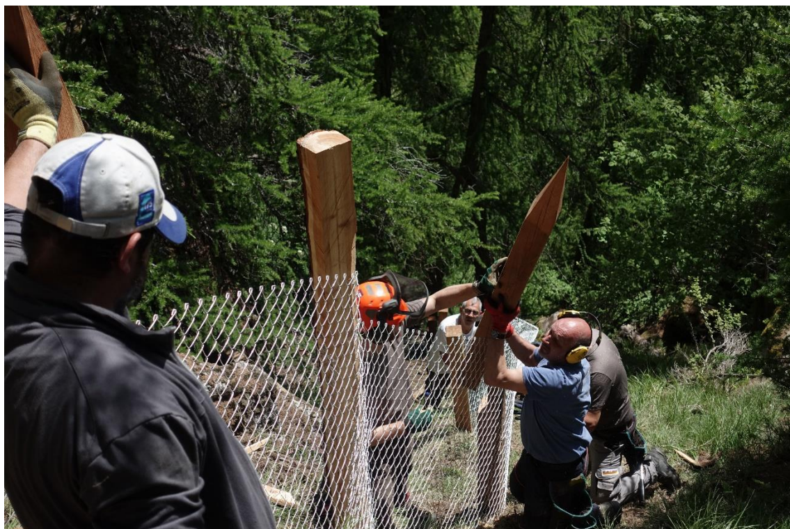
Abbildung 2: Reparatur eines Zaunabschnittes in sehr steilem Gelände. (Bild: Bergwaldprojekt)
