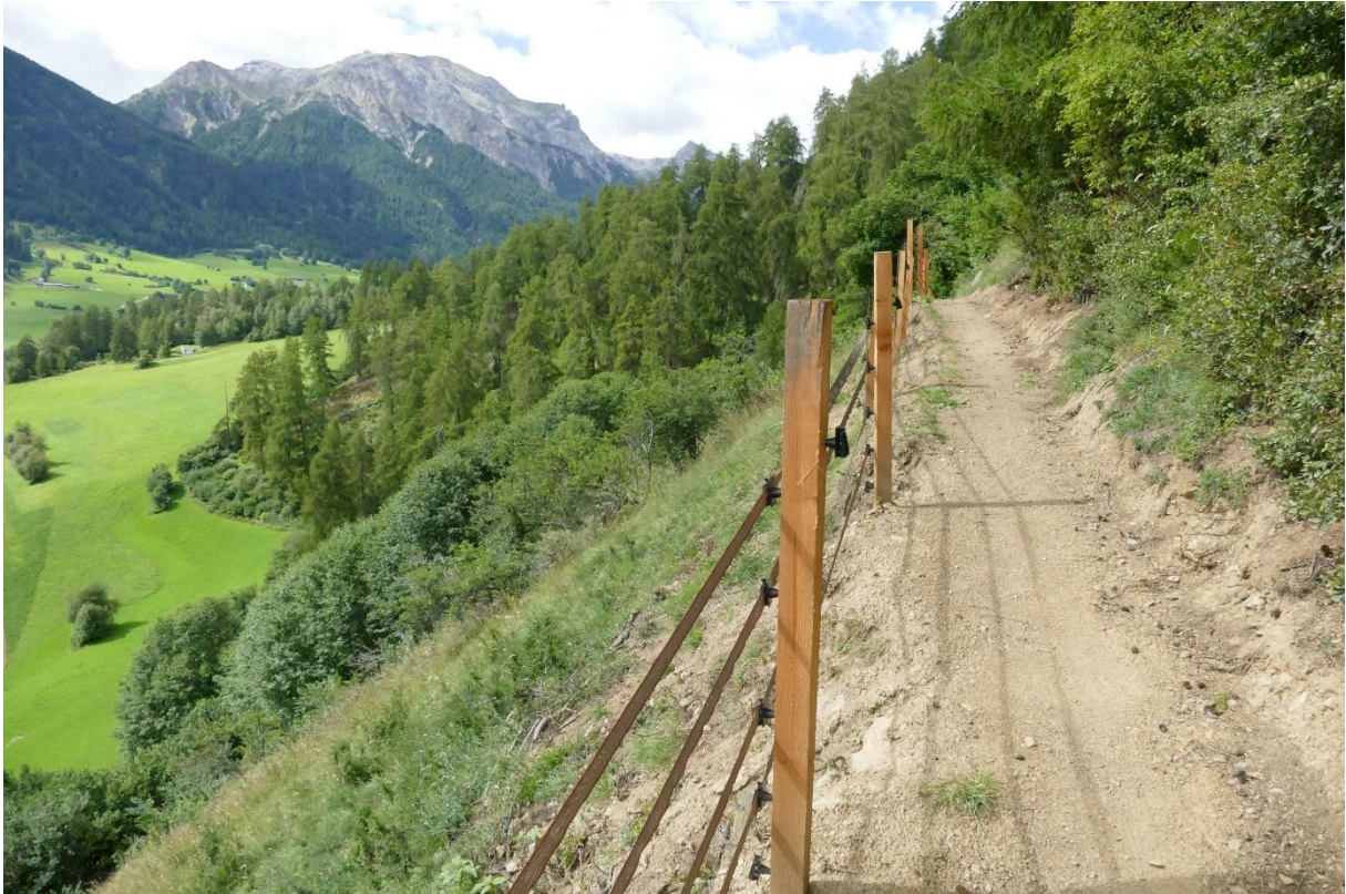
Abbildung 8: Der neue Zaun mit Lärchenpfosten und Bändersystem. Dadurch wird die Bewirtschaftung der Ziegenkoppel erleichtert, da defekte Stellen kostengünstig von einer einzelnen Person unterhalten werden können.
