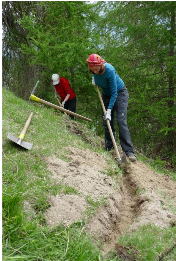
Abbildung 9 + 10: Der Graben für die Wasserleitung zu den neuen Weidebrunnen wird von Freiwilligen des Bergwaldprojektes vorbereitet.
