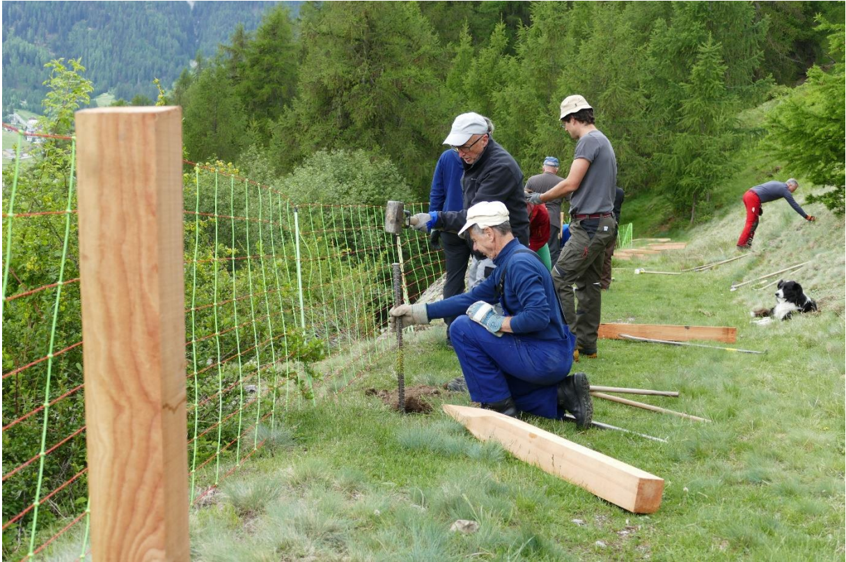
Abbildung 6: Vor dem Einrammen der Zaunpfosten mussten die Löcher jeweils vorbereiten werden.
