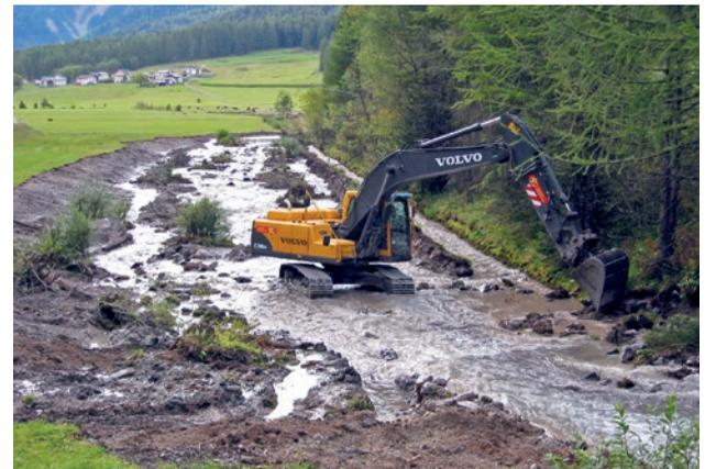
Baubeginn der Revitalisierung 2004. Rechts im Bild ist noch der ursprünglich kanalisierte Rom zu sehen.
